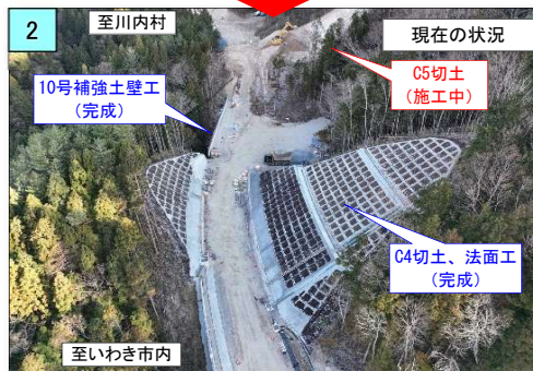
10号補強土壁工、C4切土及び法面工が完成しました。
