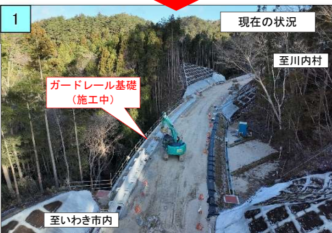
9号補強土壁上部のガードレール基礎を設置しています。
