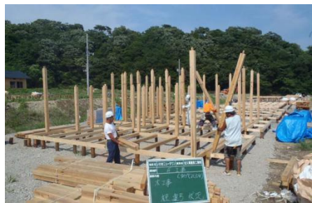
工事状況（イメージ）
