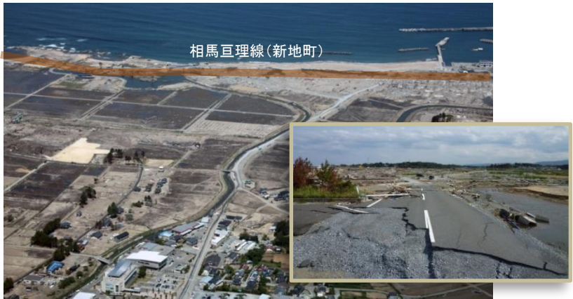
〔県道 相馬亙理線と周辺の津波被害〕
