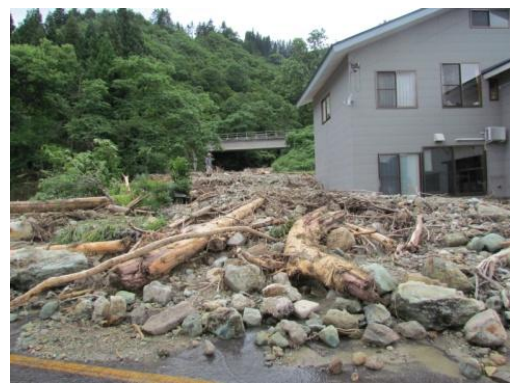
御東沢(只見町) 【新潟・福島豪雨による土砂災害】
