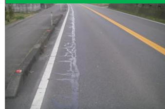
長寿命化対策（舗装補修）
