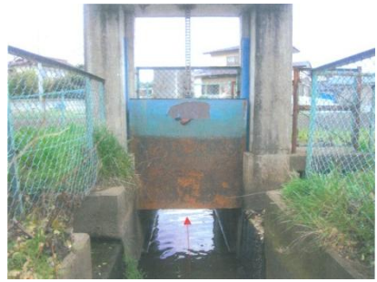
老朽化した樋門の補修
