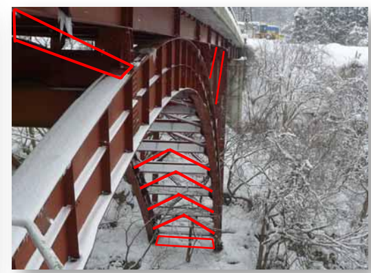
橋梁の耐震対策 (補強部材の設置)
