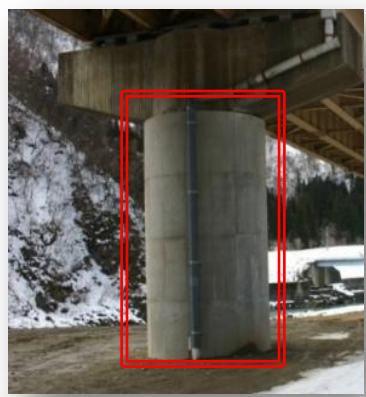
橋脚の倒壊防止対策 (ジャケット巻き立て)
