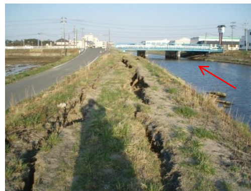
滑津川(いわき市) 【河川堤防の復旧】
