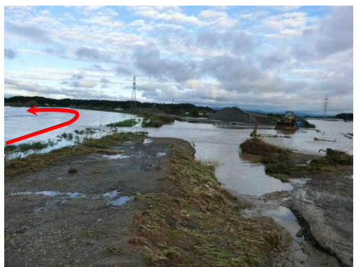
阿武隈川(玉川村) 【台風15号による洪水氾濫】
