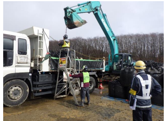
除去土壌等の積込作業
