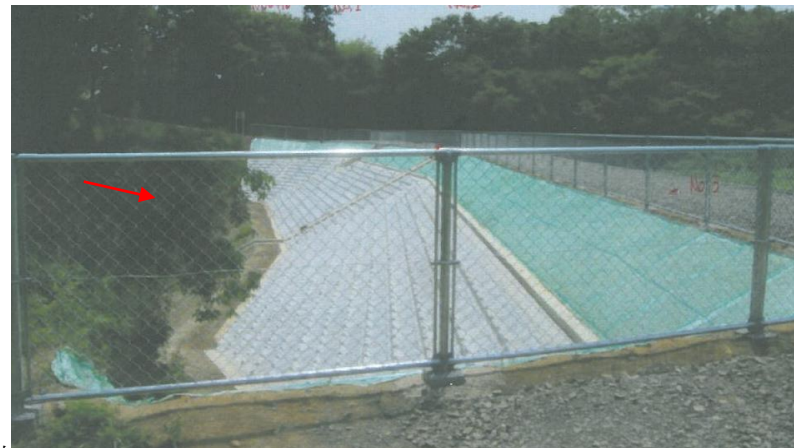
ため池堤体 (始点より)
