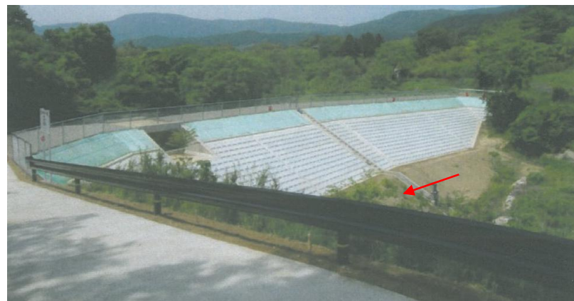
ため池堤体 (終点より)
