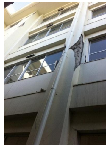
柱のせん断破壊の状況
