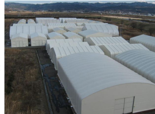
保管テント状況
