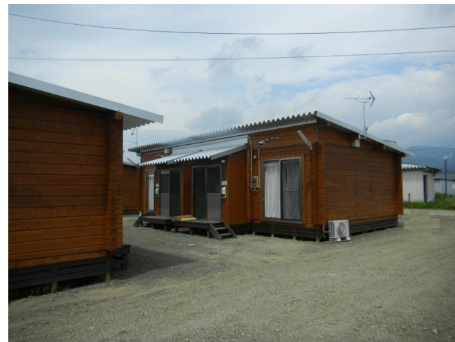
仮設住宅(木造)
