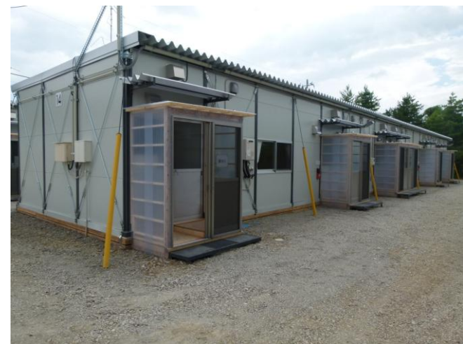
仮設住宅(鉄骨造)
