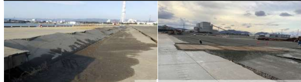
3号ふ頭岸壁 (-12m、耐震)
