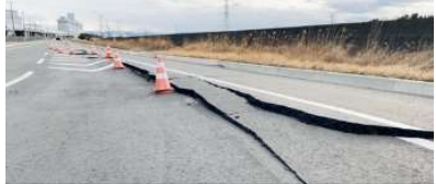
臨港道路5号ふ頭内線
