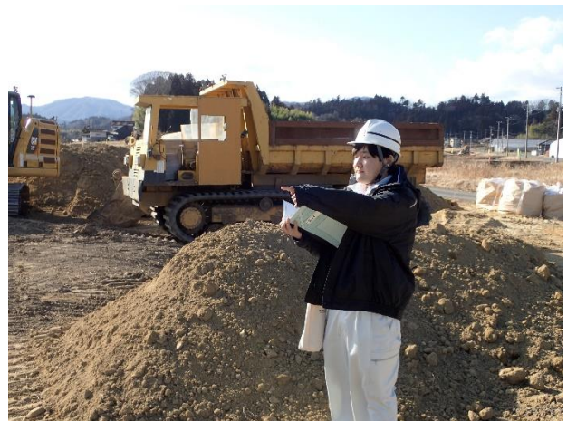
↑ 現場の施工状況確認
