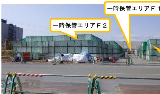
(写真1) 一時保管エリアF1、F2の概観 (エリアF2入口(東側)から撮影)
