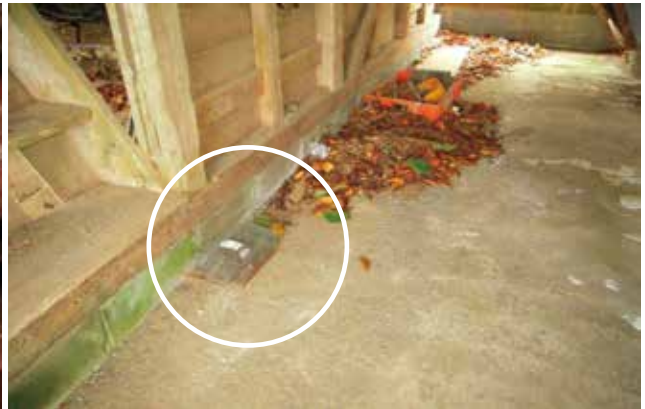
写真4 屋外かご設置状況
