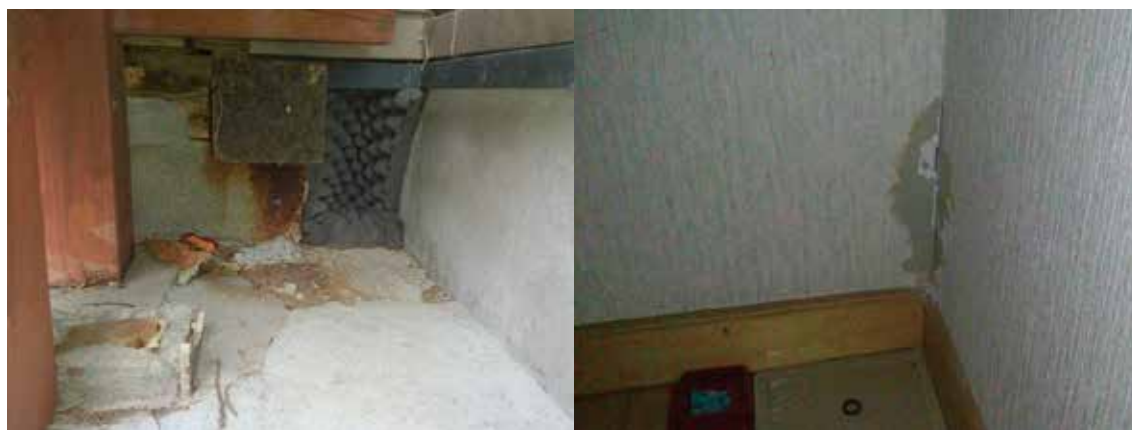
写真 10 防鼠資材の施工例：防鼠スポンジ（左）、防鼠パテ（右）
