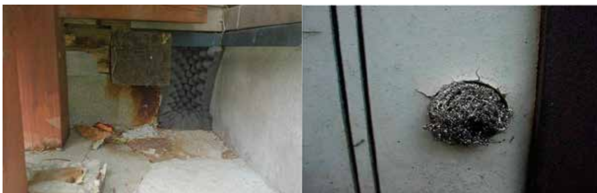
写真7 ネズミ侵入経路の遮断 防鼠スポンジ（左）、金属たわし（右）
