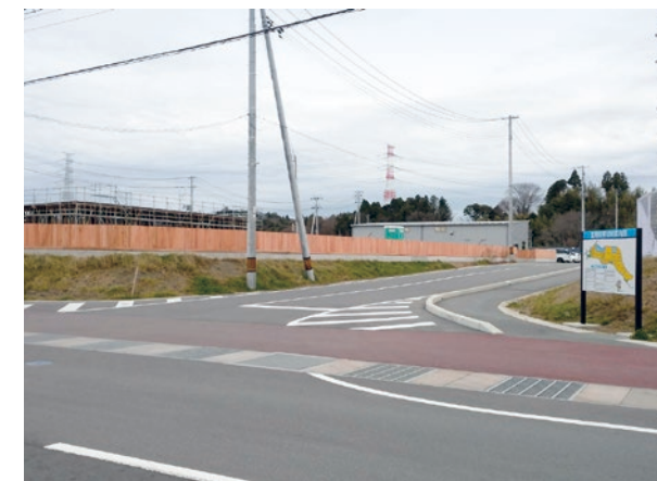
富岡町産業団地内「縦ログ・パネルログ構法研究棟兼工場」
