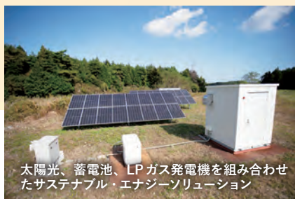
蓄電池システムは地元産業の支援を視野にリチウム電池のほか、福島で生産された鉛蓄電池をメインに採用
