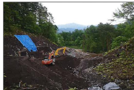
1号砂防えん堤 現在は掘削作業を行っています。
