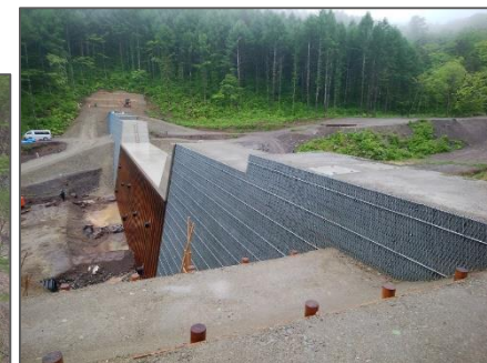
2号砂防えん堤 本体工は概ね完了し、 現在は法面対策、護岸工等の工事を 実施しています。
