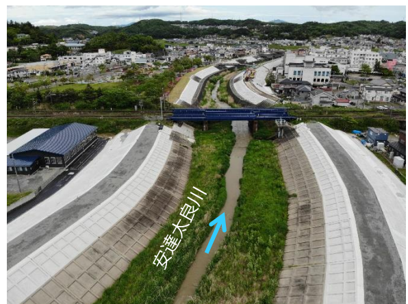
安達太良川（本宮市本宮） 堤防整備状況
