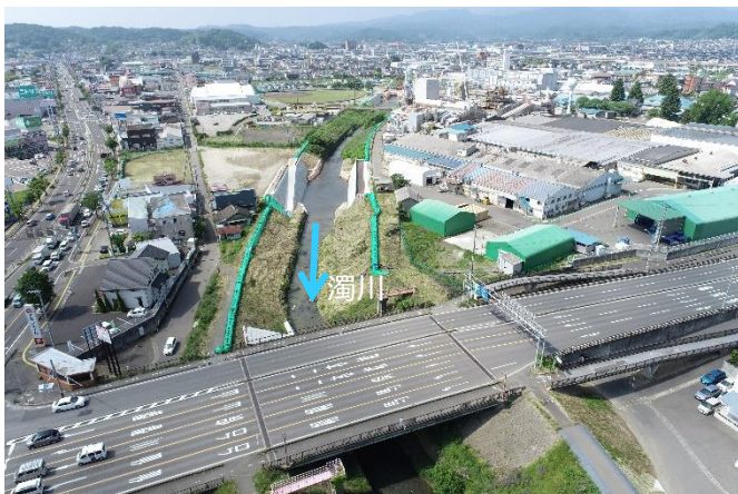
濁川（福島市鳥谷野） 堤防整備状況
