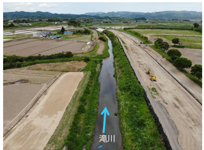
滝川（伊達郡国見町） 堤防整備状況
