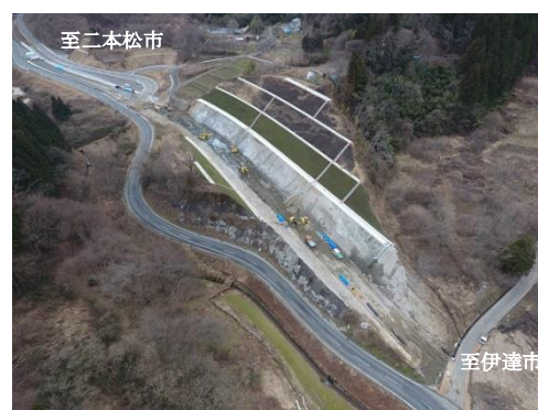
国道349号 大綱木1工区 (川俣町)
