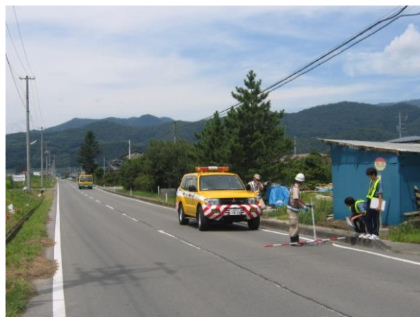
道路の異常を点検している様子
