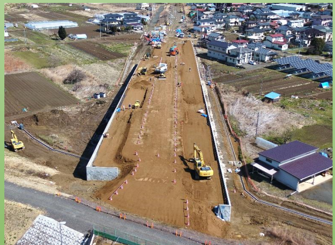
【「安らぎ」と「ゆとり」が持てる県民生活の確保】 国道349号梁川バイパス 施工状況
