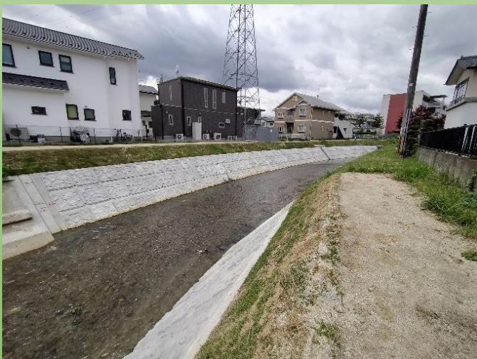
【公共災害復旧工事】 大森川筋 護岸工 完成R3.9月
