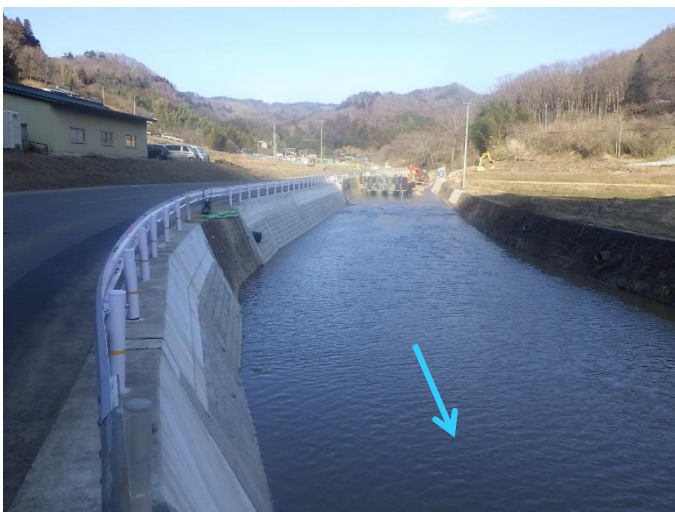
山舟生川（伊達市梁川町山舟生） 護岸整備状況
