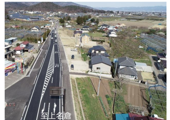
上名倉飯坂伊達線 福島大笹生2工区（福島市大笹生）
