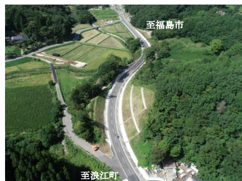
国道114号 山木屋3工区 (川俣町)
