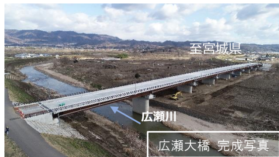
国道349号 梁川バイパス (伊達市梁川町)
