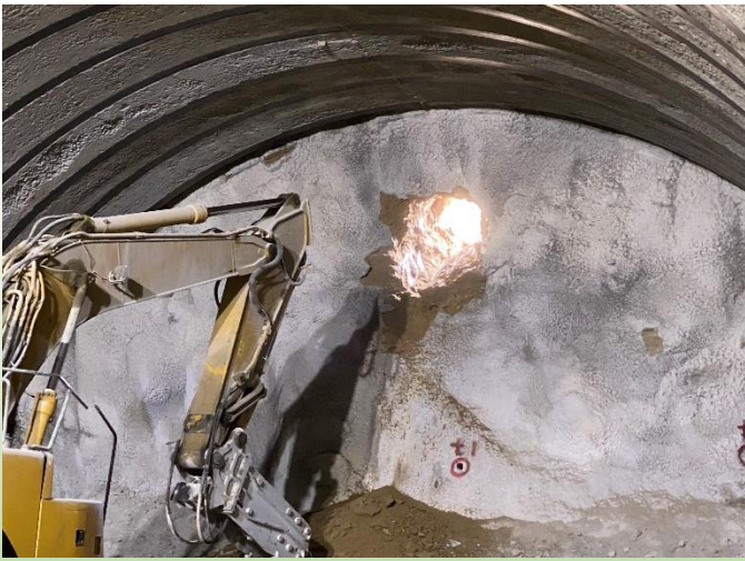
【ふくしま復興再生道路】 国道114号山木屋1工区関場トンネル 貫通R4.3月
