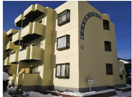
県営住宅改善工事（外壁）霞町団地 （R4.1 竣工）
