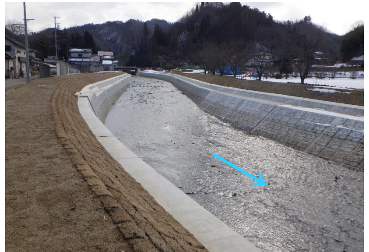
広瀬川（川俣町小島）護岸整備状況
