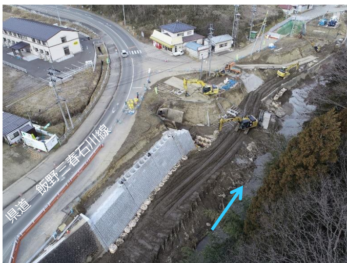
移川（二本松市上長折） 護岸整備状況
