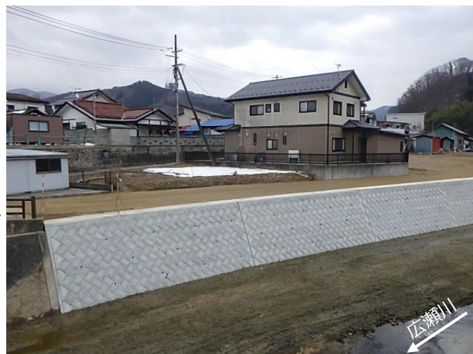
広瀬川（伊達郡川俣町川原田） 整備完了箇所
