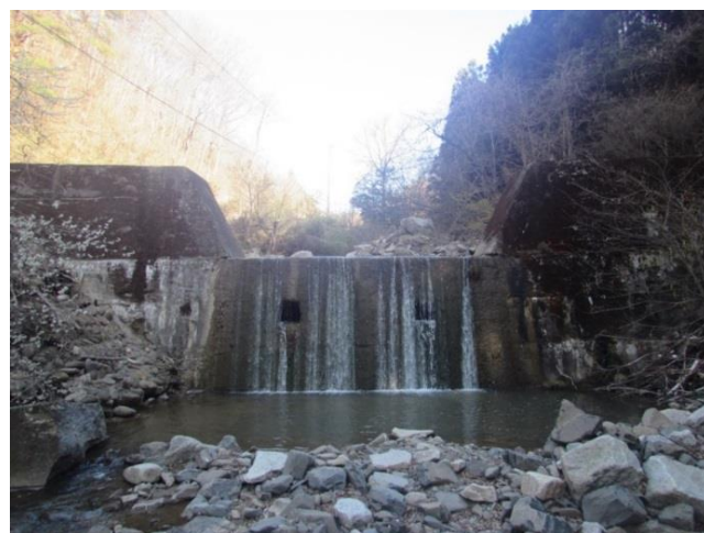
山舟生川砂防えん堤（梁川町）
