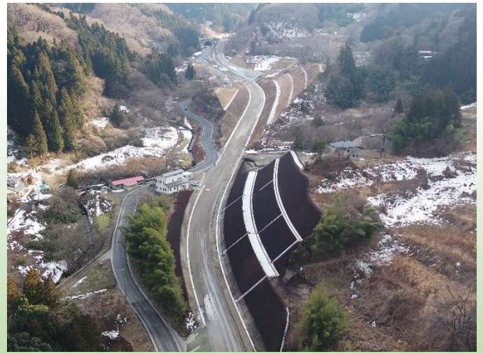
【ふくしま復興再生道路】 国道349号大綱木工区 施工状況
