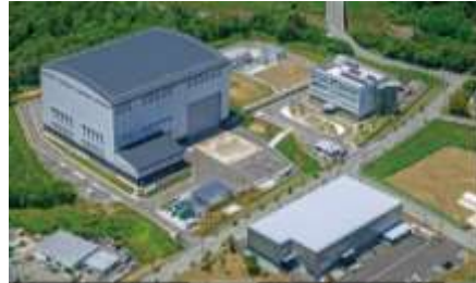
楡葉遠隔技術開発センター (楡葉町)
