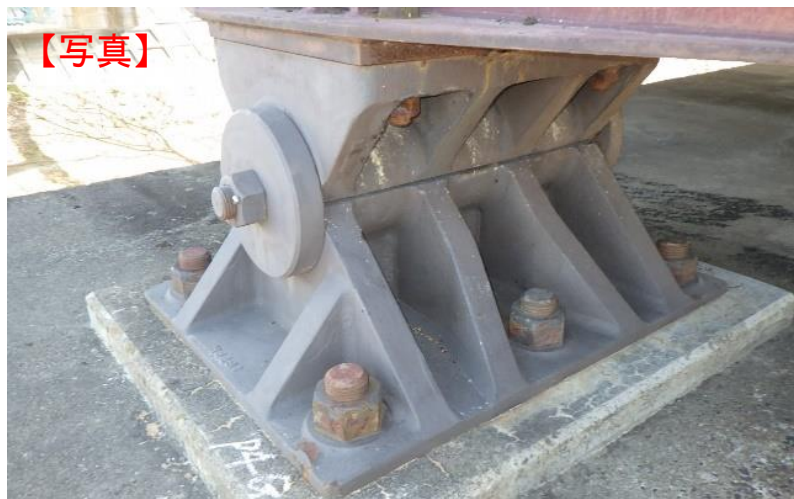
【P4橋脚 支承】 推進費を活用し、ゴム支承に更新
