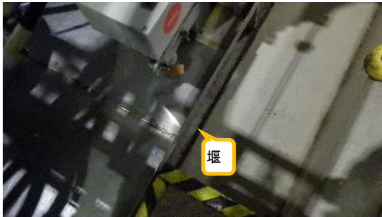
(写真1-2) 装置周辺を取り囲む堰の状況
