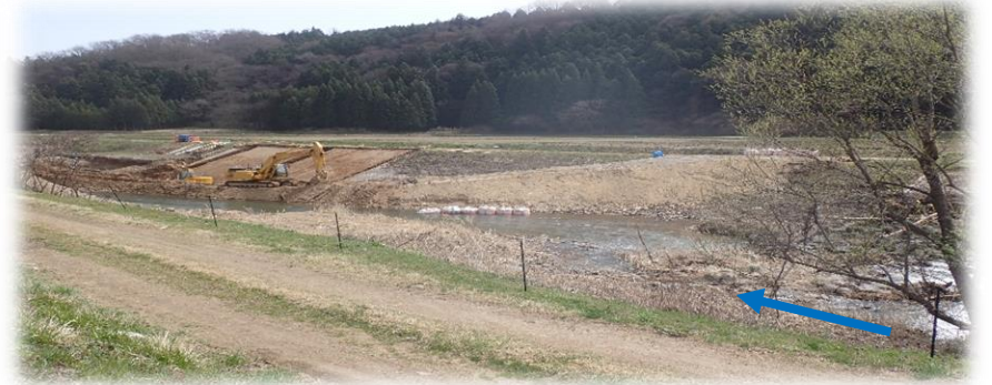
上流(左岸)から下流を望む
