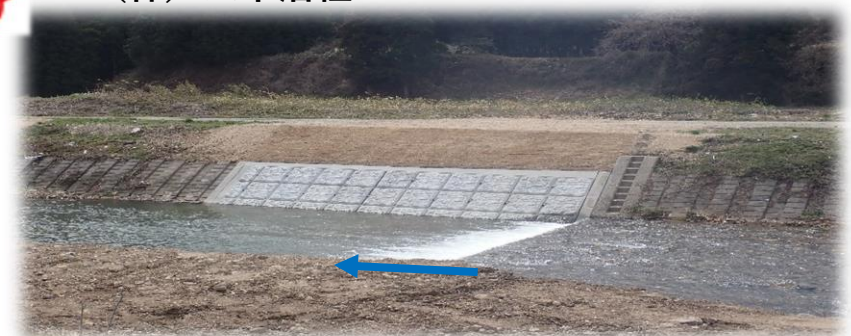
上流(左岸)から下流を望む
