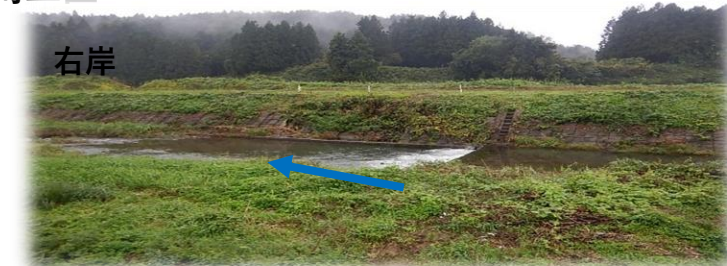
上流(左岸)から下流を望む
