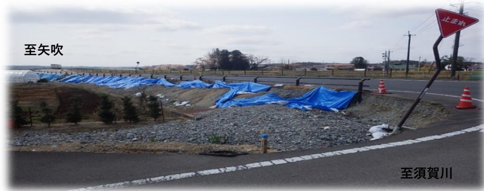
須賀川方面から矢吹方面を望む
