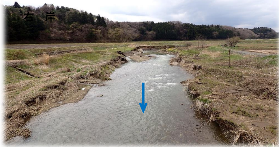
里橋から上流側 下流から上流を望む
