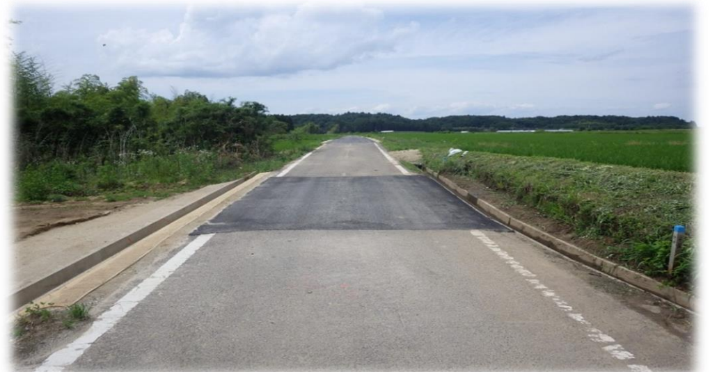
須賀川方面から二本松方面を望む
