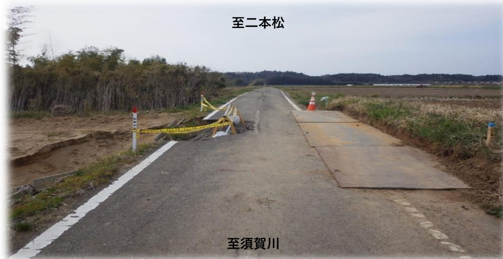
須賀川方面から二本松方面を望む
