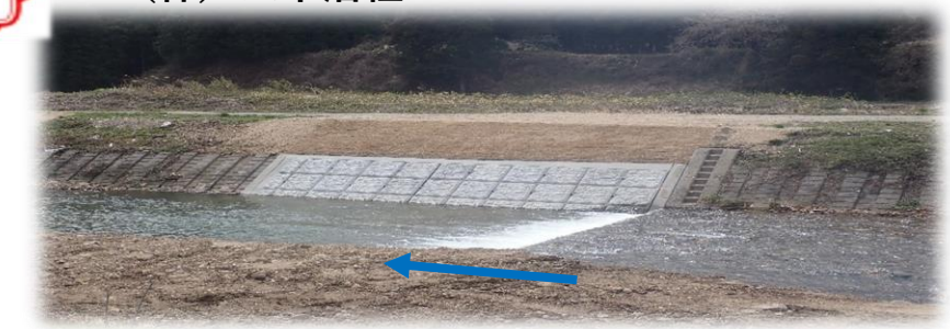
上流(左岸)から下流を望む
