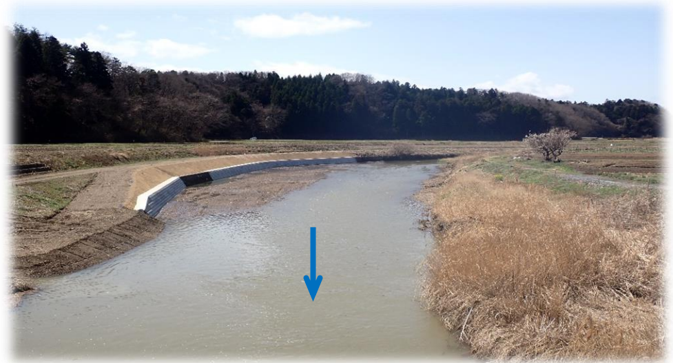
里橋から上流側 下流から上流を望む
