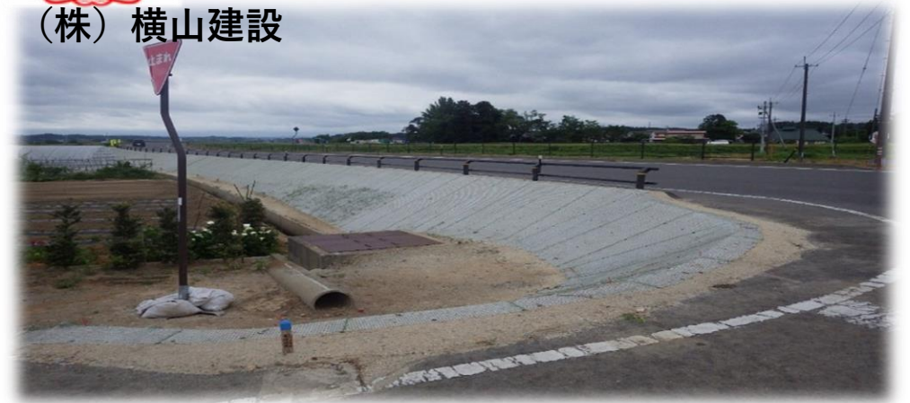
須賀川方面から矢吹方面を望む
