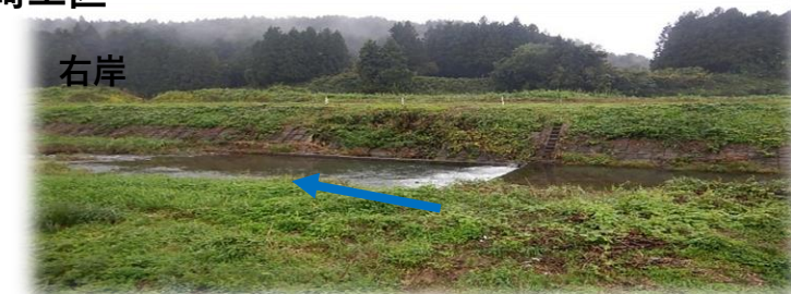
上流(左岸)から下流を望む
