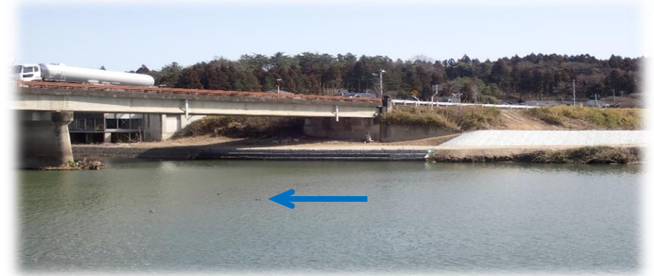
左岸から右岸を望む
