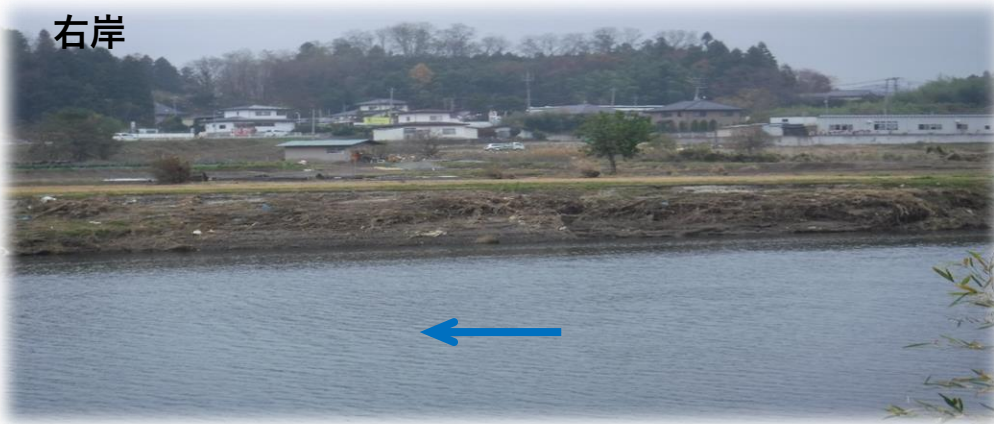
左岸から右岸を望む
