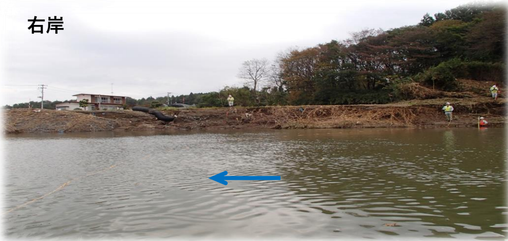
左岸から右岸を望む
