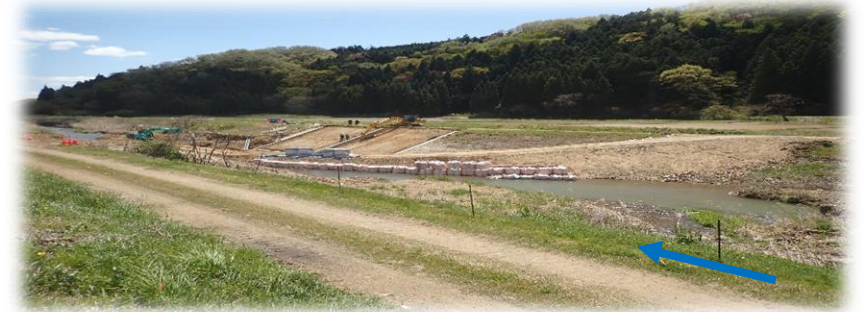
上流(左岸)から下流を望む
