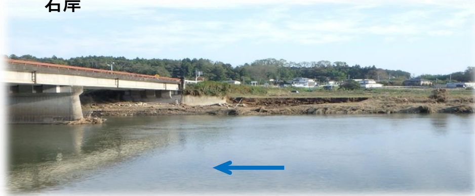
左岸から右岸を望む
