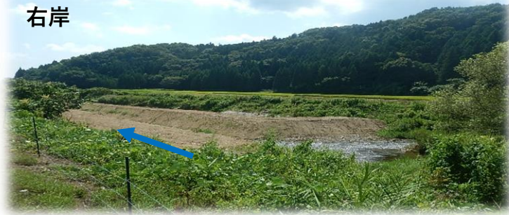
上流(左岸)から下流を望む
