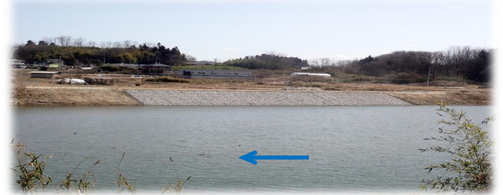
左岸から右岸を望む
