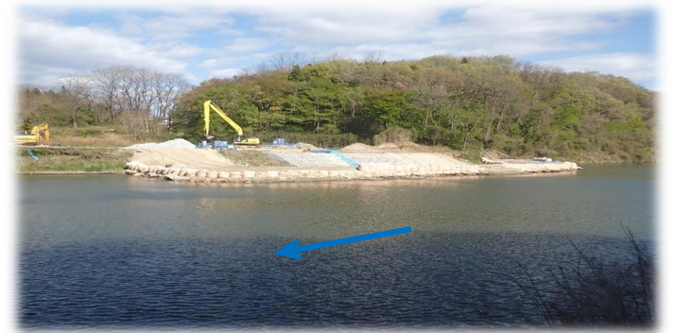
左岸から右岸を望む
