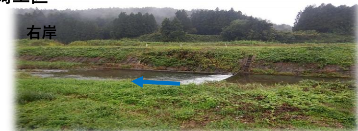
上流(左岸)から下流を望む
