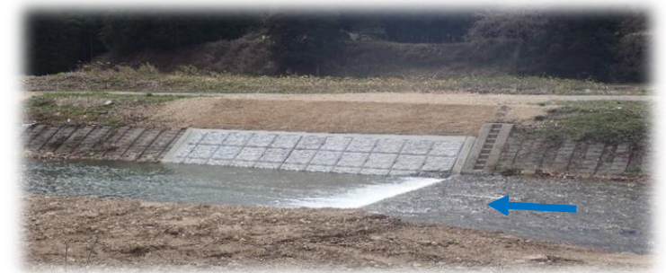
上流(左岸)から下流を望む
