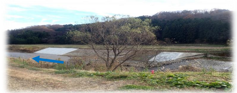
上流(左岸)から下流を望む
