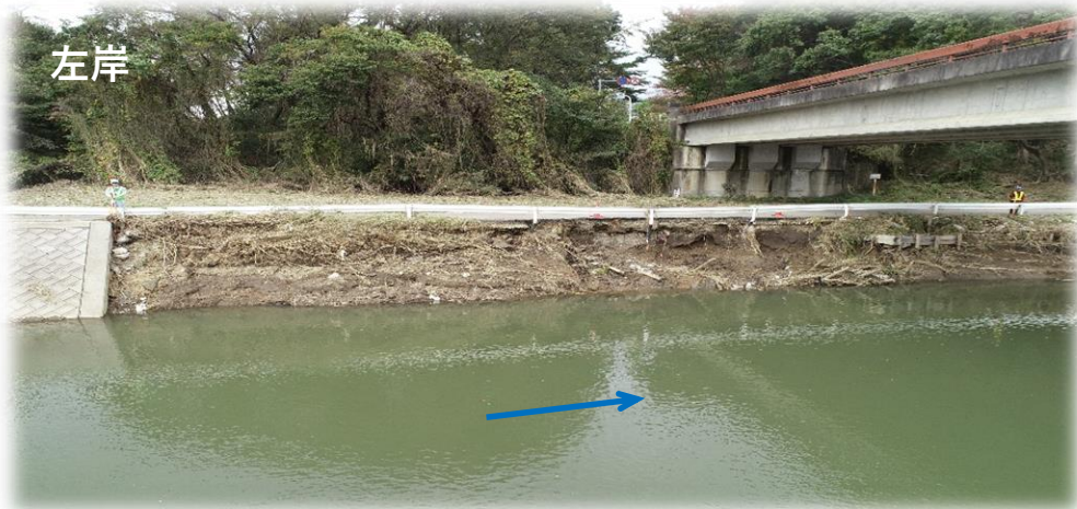
右岸から左岸を望む
