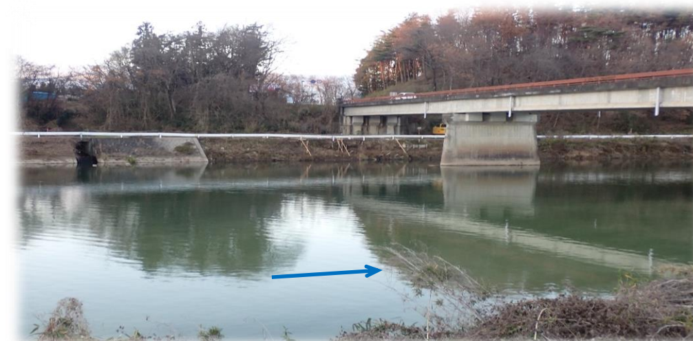
右岸から左岸を望む
