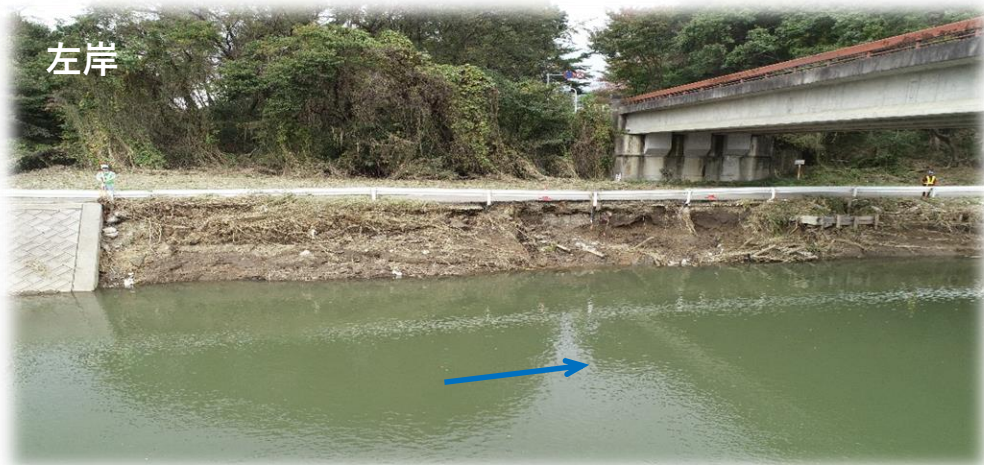
右岸から左岸を望む
