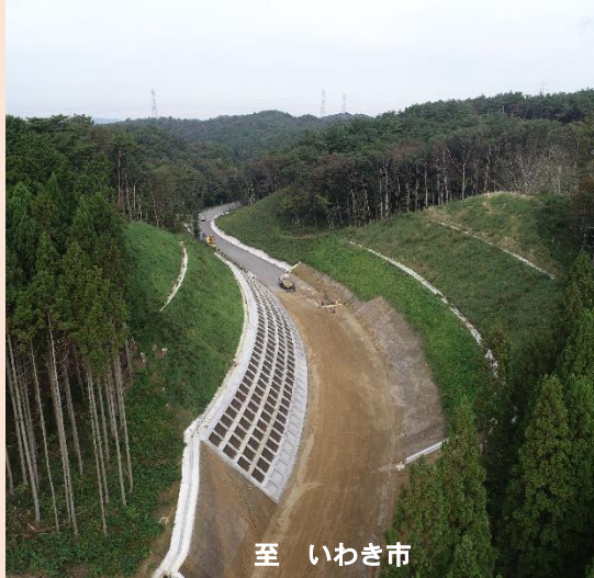
② 2工区 法面工事状況
