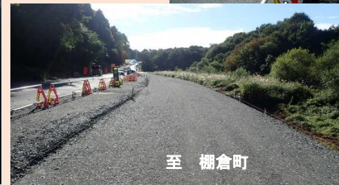
② 2工区 路面掘削状況 (片側交互通行)
