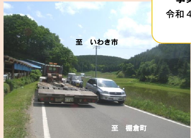
工事着手前 (平成25年度)
