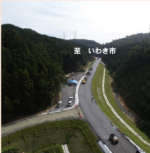
① 2工区 舗装施工状況
