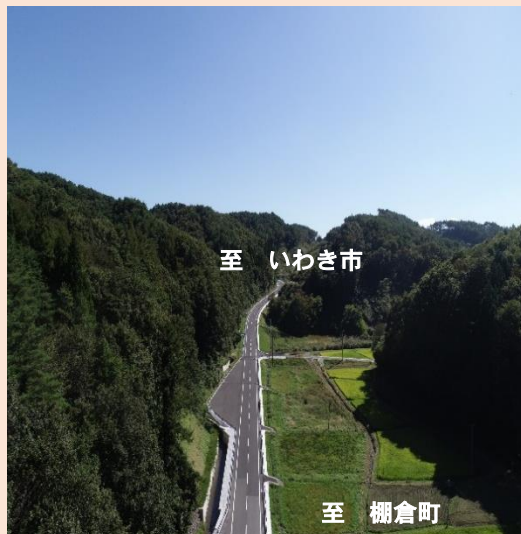
③ 3工区 舗装完了状況
