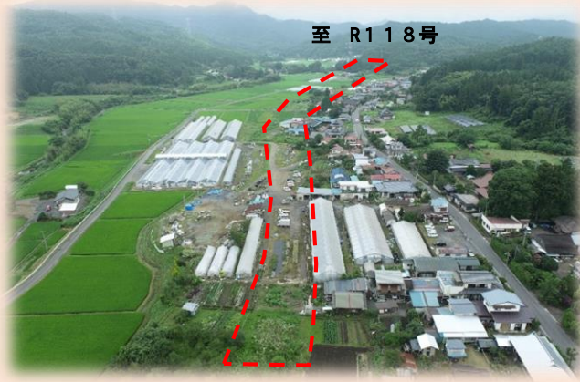
①整備前 (2工区)
