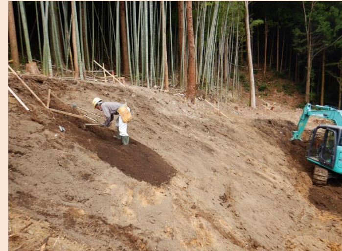
施工状況写真
