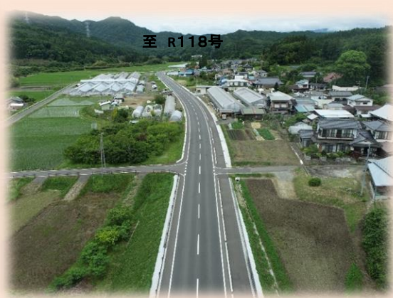
②整備後 (2工区)
