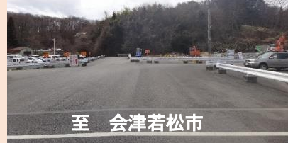
工事着手前 (平成29年度)
