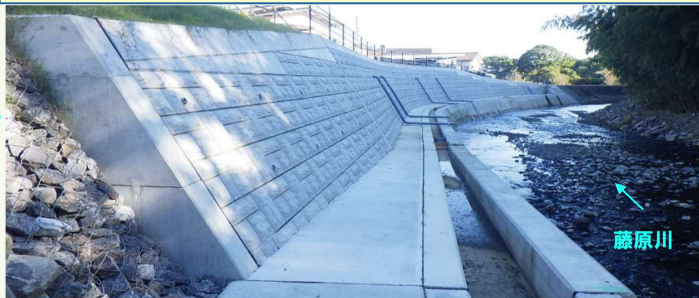
護岸工事 (完了)
