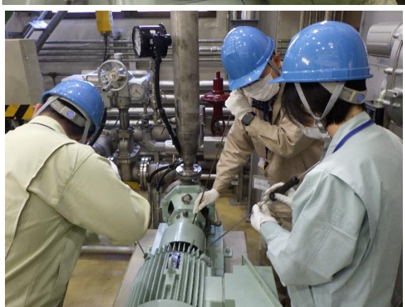
ループ設備試運転中のポンプと電動機の健全性確認（聴診棒による聴診）の様子
