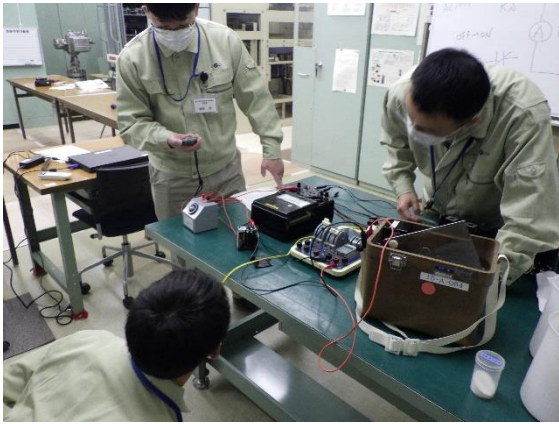
電源盤等の動作確認実習の様子
