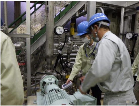
ポンプの回転数を測定している様子
