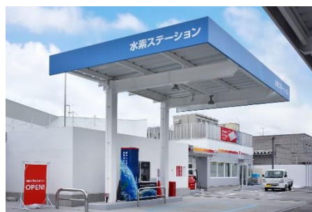
水素ステーション「エネルギー Park 郡山南」
