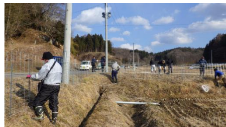
〈地域住民主体で取り組む防除柵設置作業〉
