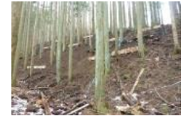
移動抑制対策(筋工)
