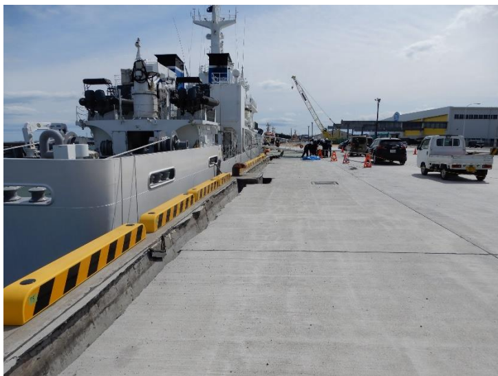
地震により生じた傾き・段差の復旧 相馬港1号ふ頭(相馬市)
