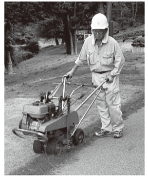
除染作業の様子。芝の深刈りを行い、芝に付着した放射性物質を除去します。
