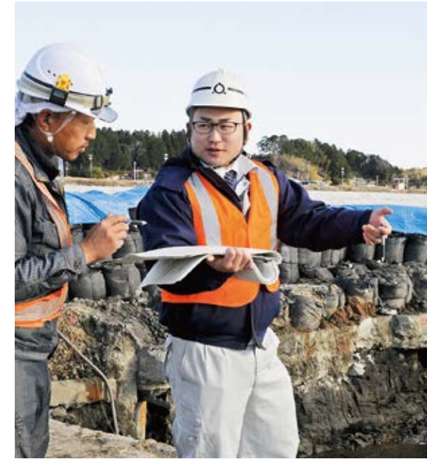
設計図を確認しながら、工事の状況をチェックします。
