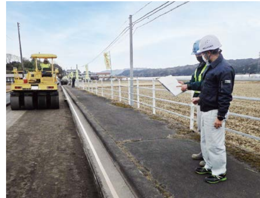
設計どおりに工事が進んでいるかを現場で確認します。
