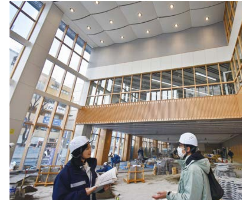
工事の各段階で職員が現場で施工状況を確認します。
