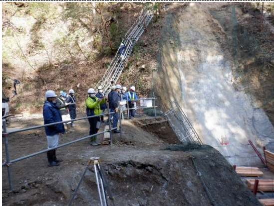
【受発注者合同安全パトロールの実施状況】
