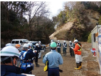
令和 4 年度安全パトロール実施状況
