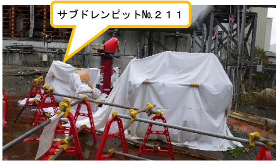
(写真5-1) サブドレンピットNo.211の状況 (北西側から撮影)
