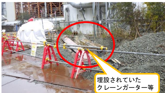
(写真2) ヤード南西エリアの状況 (北西側から撮影)
