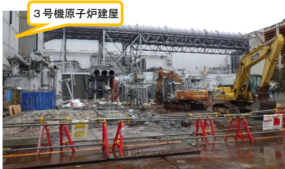
(写真3-1) ヤード東側の状況 (西側から撮影)
