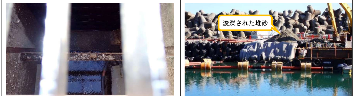
(写真1-3) 5号機取水路の状況 上部から撮影。堆砂が撤去されている。
