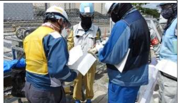
(写真2-1) 外観検査の状況
