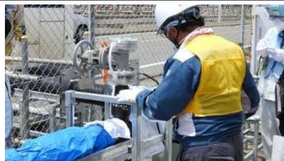
(写真2-2) 据付検査の状況
