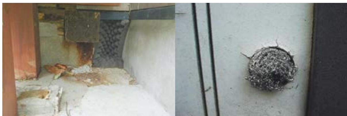
写真7 ネズミ侵入経路の遮断 防そスポンジ（左）、金属たわし（右）
