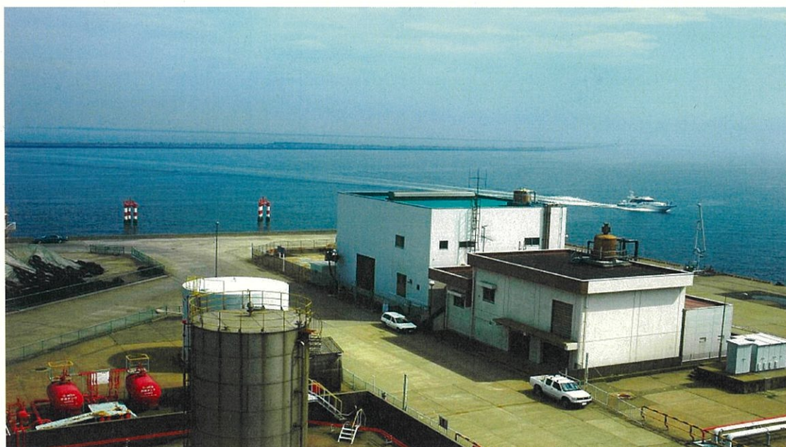
【小名浜ポンプ場】
