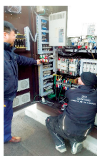
安川インバータ トルクリミット改善作業
