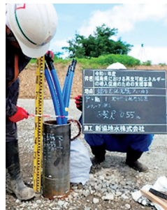
\alpha ウイングパイルによる 地中熱交換器設置の実証
