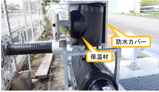
(写真3-1) ベント弁1の状況
