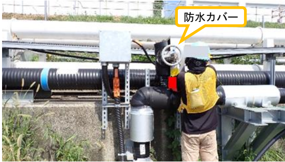
(写真3-2) ベント弁2の点検作業の状況
