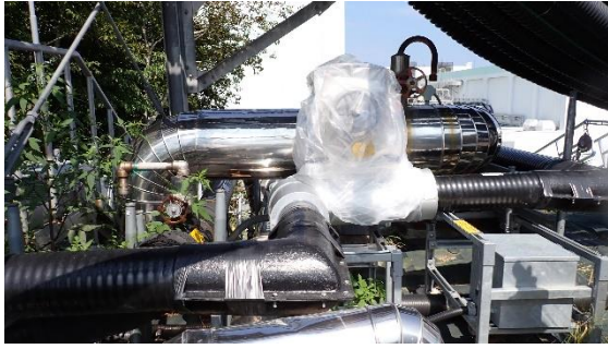
(写真3-5) ベント弁6の状況
