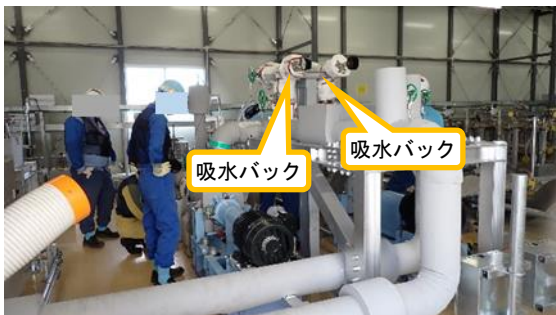
(写真2) 圧力計の点検状況② (多核種移送設備建屋内)
