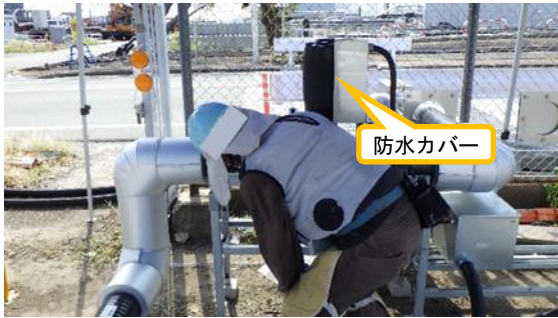
(写真4) ベント弁1の復旧作業の状況
