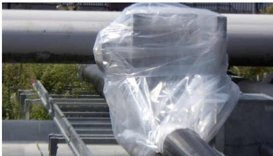
(写真3-3) ベント弁3の養生状況
