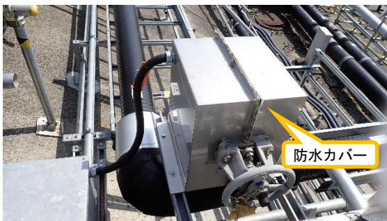
(写真3-4) ベント弁4の状況
