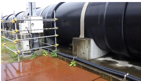
(写真4-1) BC排水路（海側）の状況
