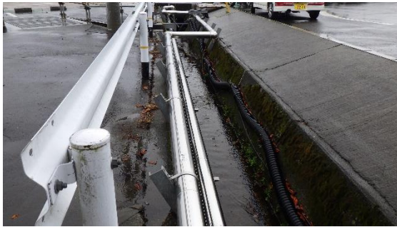
(写真1-2) C排水路の状況
