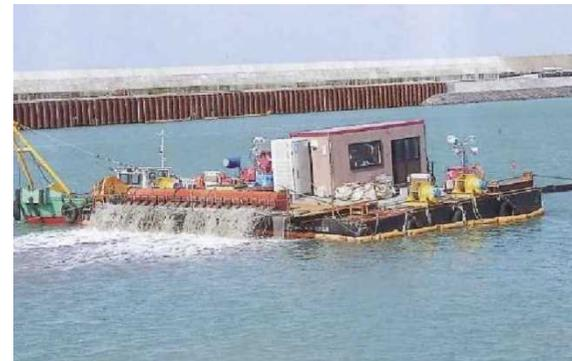
図3.ユニフロート台船による覆砂工事
