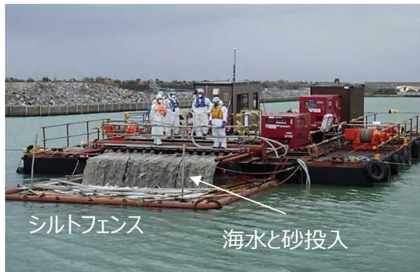
ユニフロート台船による覆砂投入状況
