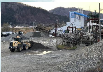
写真：骨材生産状況
