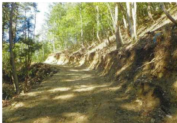
作業道開設（施工後）
