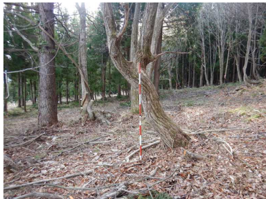
緩衝帯整備後の様子
