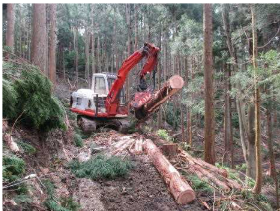
作業路の整備（施工中）
