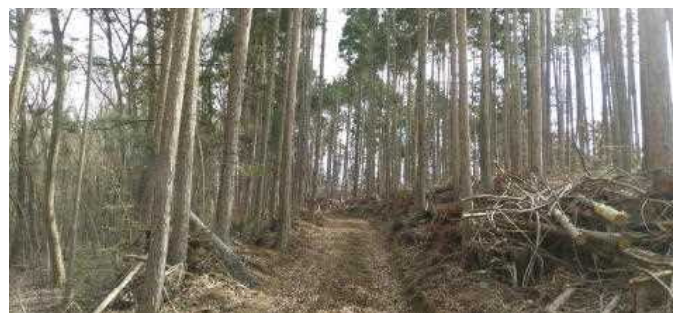
作業路の整備（施工後）
