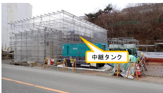
(写真4-1) 中継タンク概観 (北西側から撮影)
