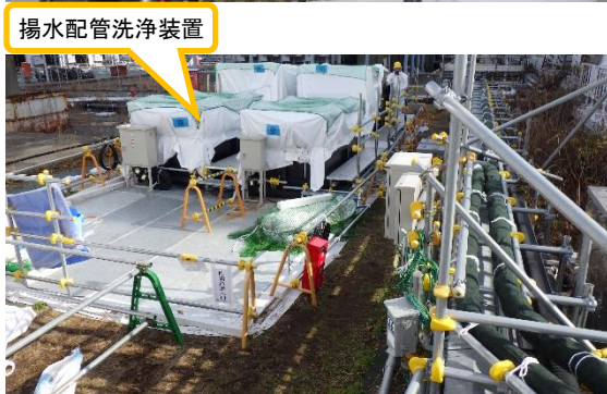
(写真3-3) 揚水配管洗浄装置設置途中の例 (南西側から撮影)
