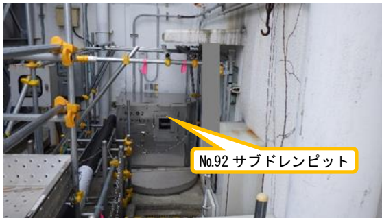
(写真3-2) 点検用檣等設置途中の例 (No.92サブドレンピット) (西側から撮影)
