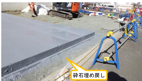
(写真2-2) 汚染土壌撤去後の状況② (南東側から撮影)
