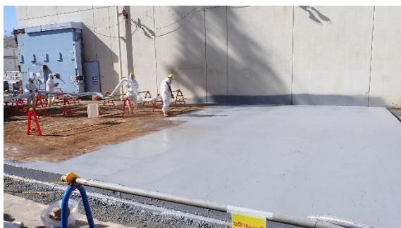
(写真 3-1) ポリウレア吹き付け作業の状況① (北東側から撮影)
