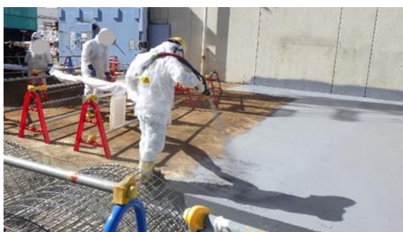
(写真 3-2) ポリウレア吹き付け作業の状況② (北東側から撮影)
