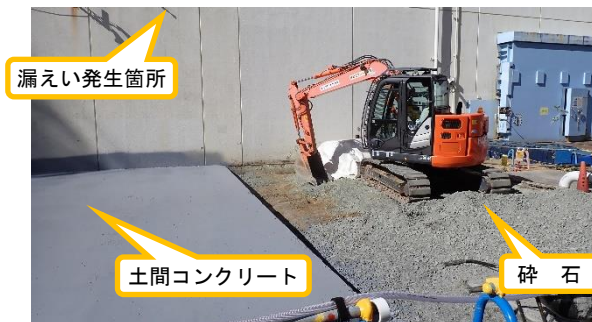
(写真2-1) 汚染土壌撤去後の状況① (東側から撮影)
