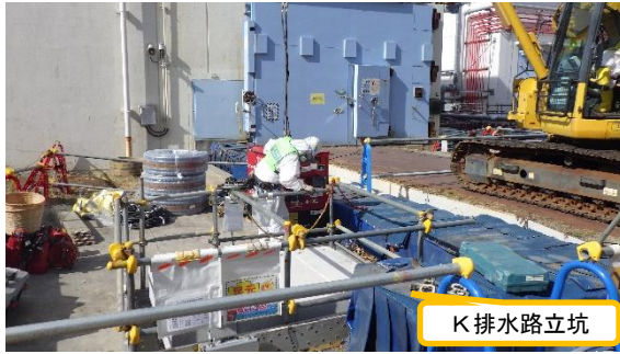
(写真3) K排水路バイパス工事の準備状況
