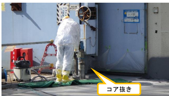
(写真2) コア抜きの状況 (北東側から撮影)
