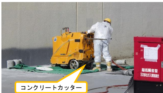
(写真1-2) コンクリートカッターでの作業状況 2 (南東側から撮影)
