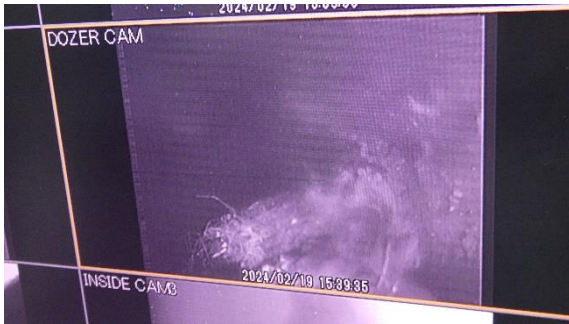
(写真4-3) 監視用ディスプレイ (X-6 ペネ内の映像、高圧水噴射後)
