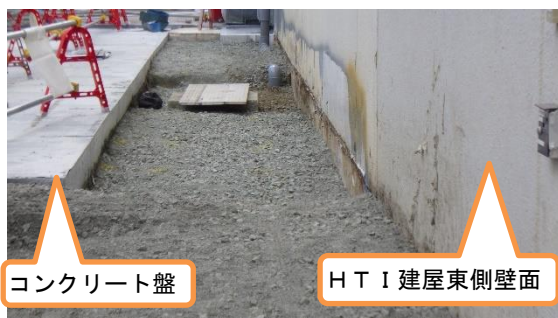
(写真1) コンクリート盤の西側汚染土壌回収部の状況(北側から撮影)
